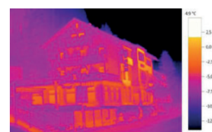
Image thermique avec testo ScaleAssist
